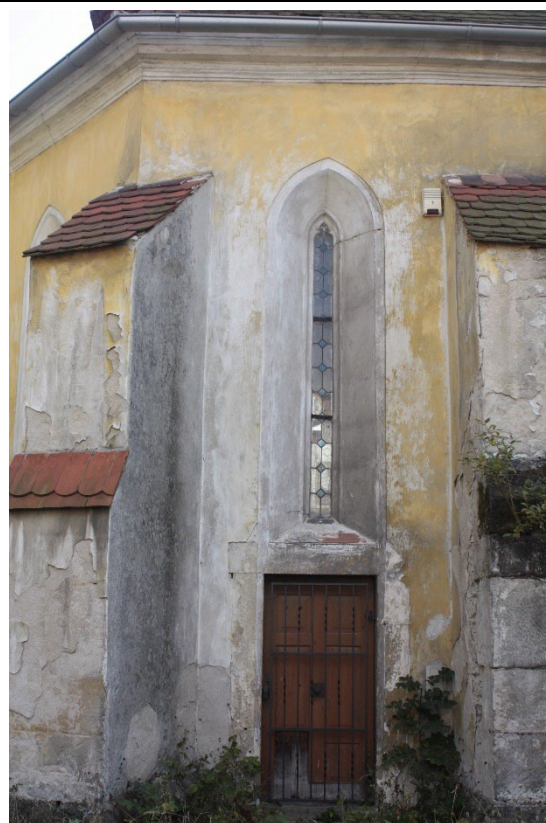
Detail severního pole presbytáře v pohledu od severu. Foto: Jaroslav Skopec 2011.
