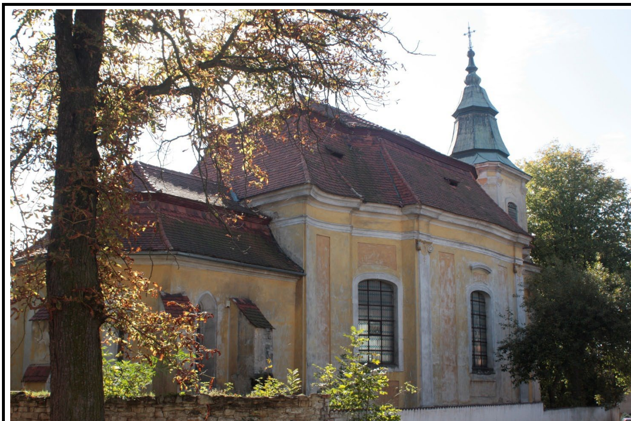
Celkový pohled od severovýchodu. Foto: Jaroslav Skopec 2011.
