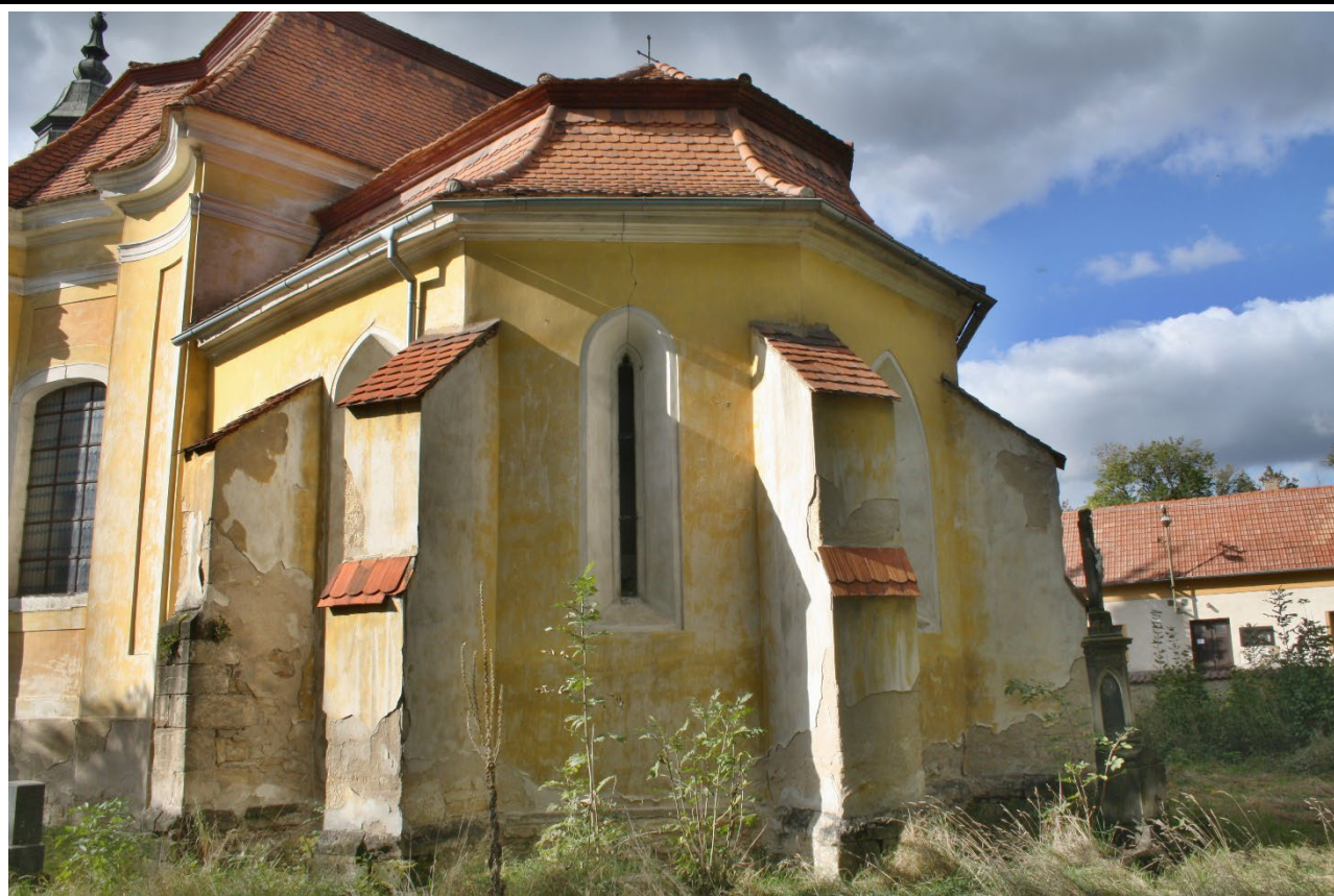
Presbytář v pohledu od jihovýchodu. Foto: Kateřina Neumannová 2016.
