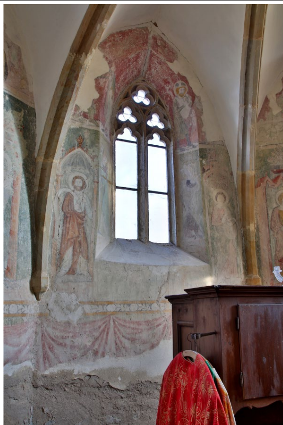
Východní pole presbytáře v pohledu od severozápadu. Foto: Kateřina Neumannová 2016.
