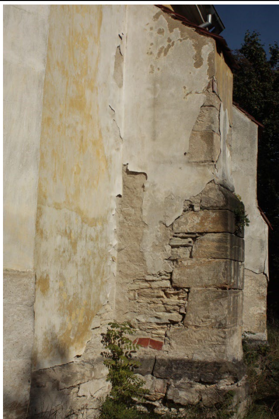
Detail jižního opěráku presbytáře v pohledu od jihozápadu. Foto: Jaroslav Skopec 2011.
