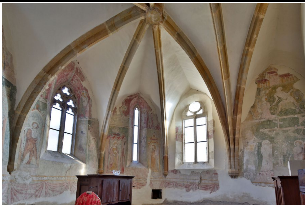
Interiér presbytáře v pohledu od severu. Foto: Kateřina Neumannová 2016.
