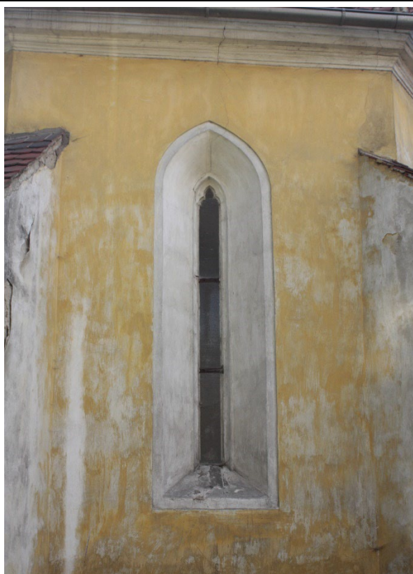
Detail severovýchodního okenního otvoru presbytáře v pohledu od severovýchodu. Foto: Jaroslav Skopec 2011.
