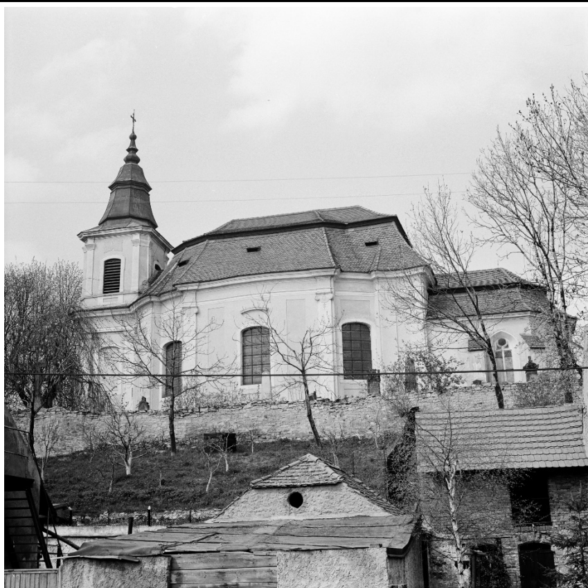
Celkový pohled od jihu. Foto: 1988, sbírka negativů NPÚ ÚOP v Ústí n. L., sig. 94510.
