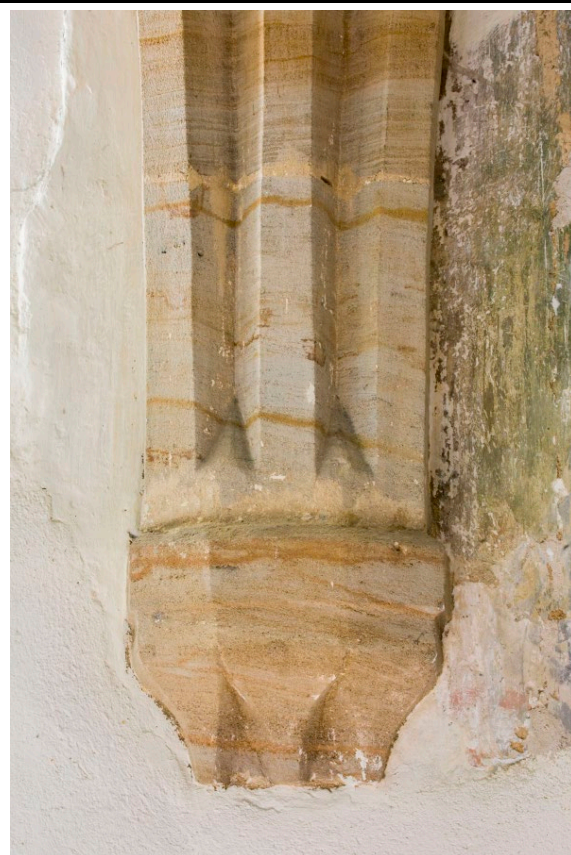
Detail jižní konzoly presbytáře v pohledu od severu. Foto: Marta Pavlíková 2019.
