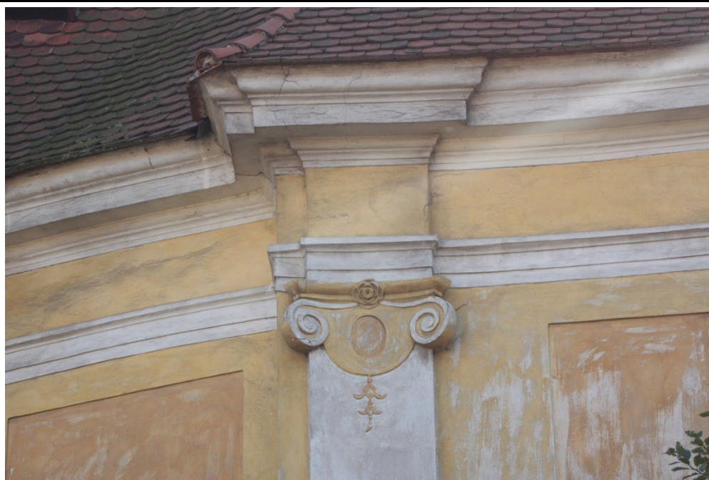
Detail korunní římsy lodi v pohledu od severu. Foto: Jaroslav Skopec 2011.
