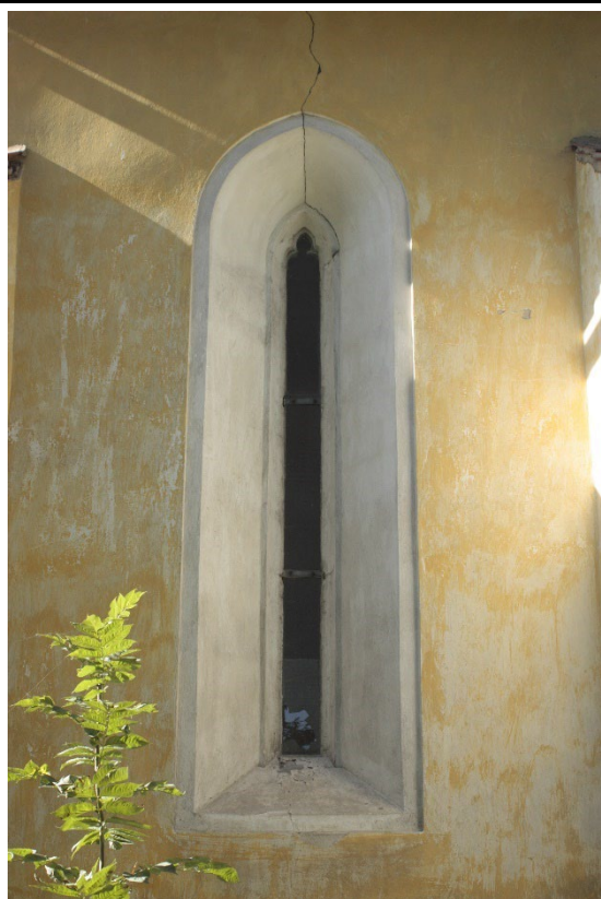
Detail jihovýchodního okenního otvoru presbytáře v pohledu od jihovýchodu. Foto: Jaroslav Skopec 2011.
